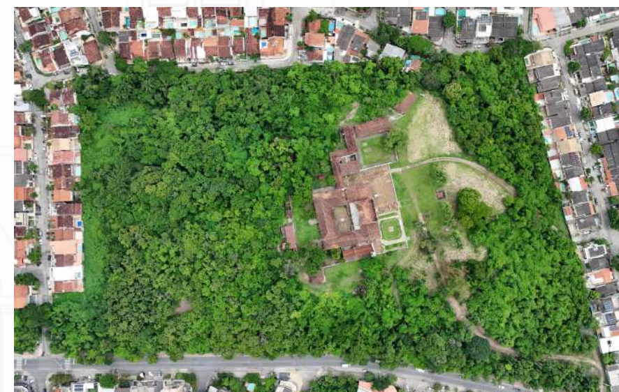
Fotografia aérea feita por drone . Vista superior do terreno.
